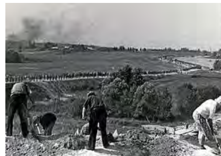
Строительство оборонительных сооружений
